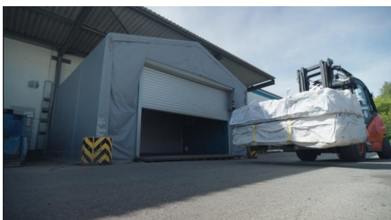
Bild 3: Beschickung der Materialschleuse des stationären Sanierungsbereichs.
