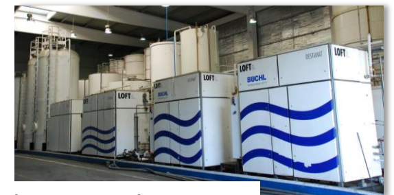
Leistungsstarke Emulsionsspaltanlage am Standort Ungarn
